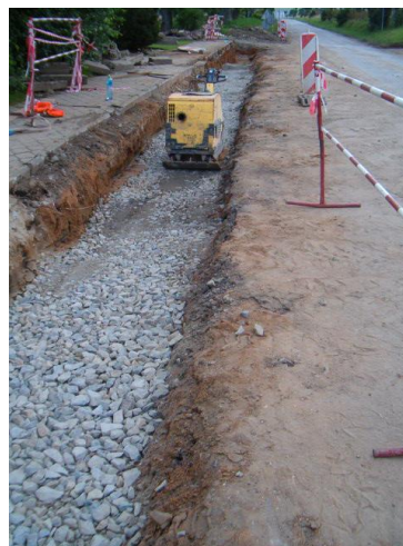
Stoka CA-4-2 – oprava komunikace III/49918 – podkladní vrstvy - hutnění
