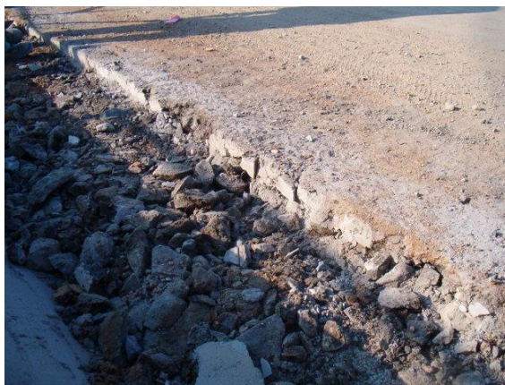
Stoka CA-4-2 – oprava komunikace III/49918 – zařezání hrany
