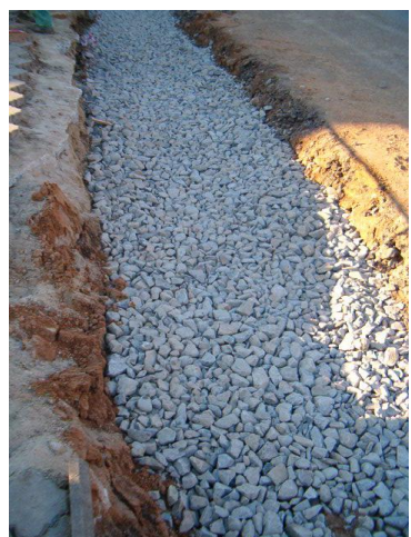
Stoka CA-4-2 – oprava komunikace III/49918 – podkladní vrstvy
