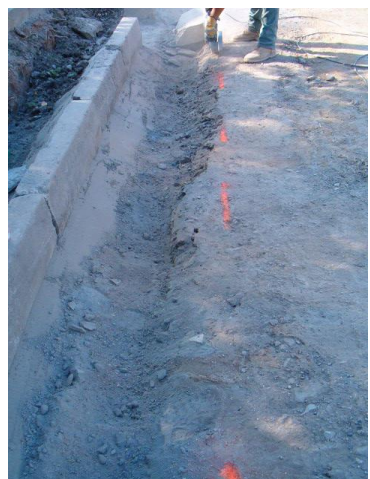
Stoka CA-4-2 – oprava komunikace III/49918 – označení zařezání hrany
