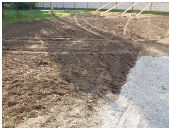
Stoka CC – uvedení povrchů do původního stavu
