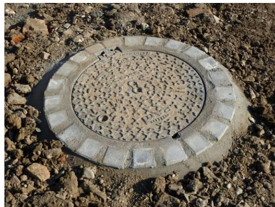
Stoka CA – odláždění kolem kanalizačních poklopů
