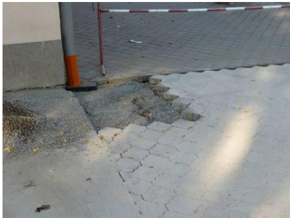
Stoka CB – práce na obnově povrchů
