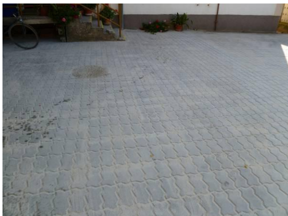
Stoka CB – uvedení povrchů do původního stavu
