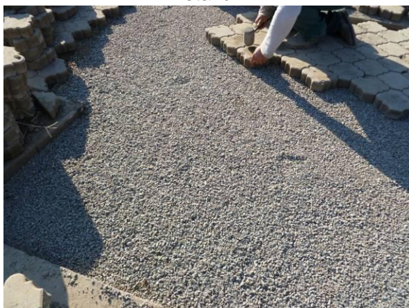
Stoka CA – práce na obnově povrchů
