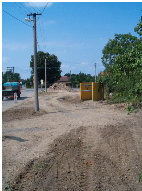
Stoka CA – terénní úpravy
