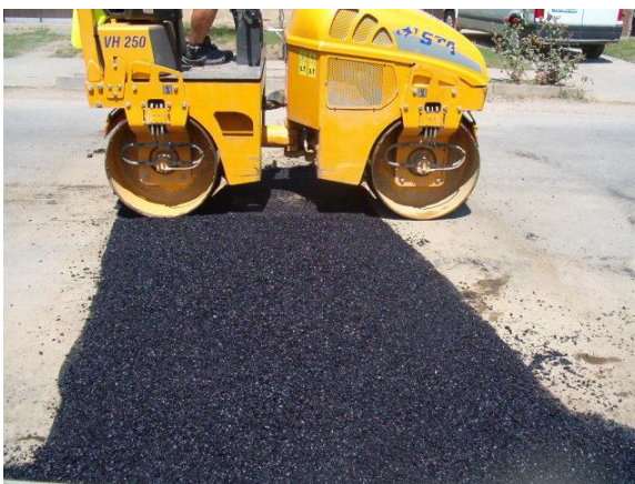
Stoka CD – oprava překopu komunikace III/4992
