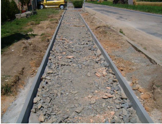
Stoka BE – chodník (příprava podkladních vrstev)
