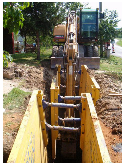
Stoka CA – výkopové práce
