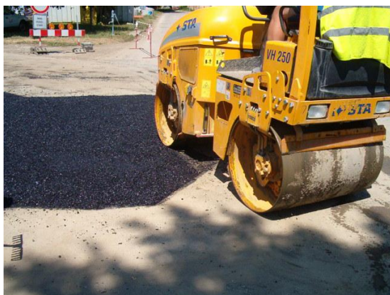
Stoka CA – oprava komunikace III/4992
