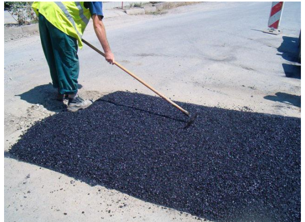
Stoka CC – oprava překopu komunikace III/4992
