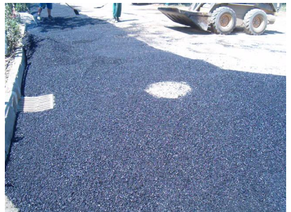
Stoka CA – oprava komunikace III/4992
