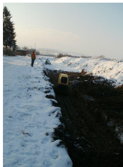
Stoka A – hutnění po výkop. pracech
