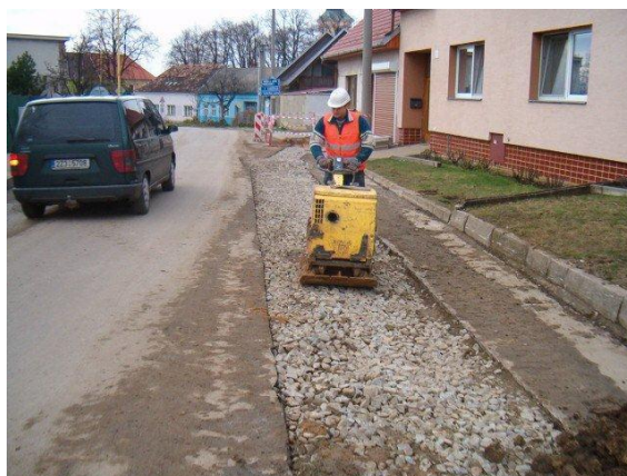
Stoka BA 1-2 – provizorní úprava komunikace
