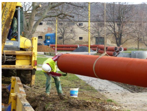
Stoka C – pokládání potrubí
