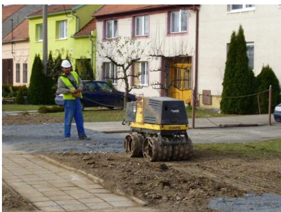
Stoka C – hutnění po výkop. pracech
