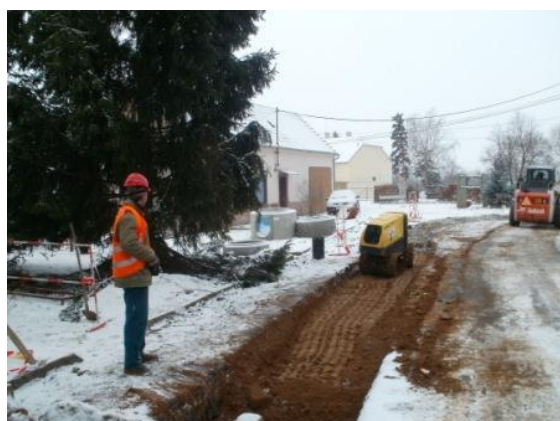
Stoka A – hutnění po výkop. pracech
