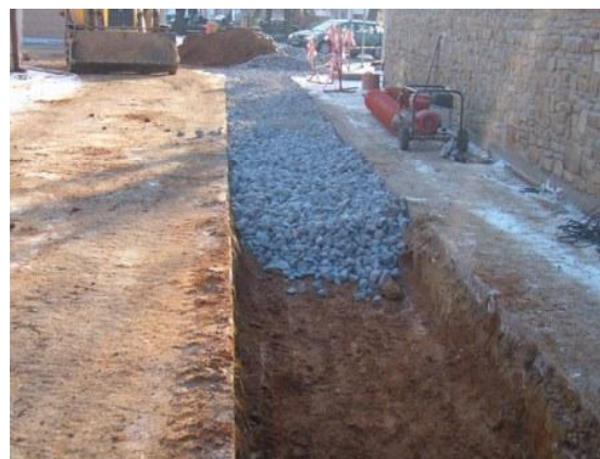
Stoka BA 1-2 – úprava komunikace
