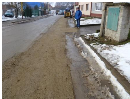
Stoka BA 1-1 – provizorní úprava komunikace
