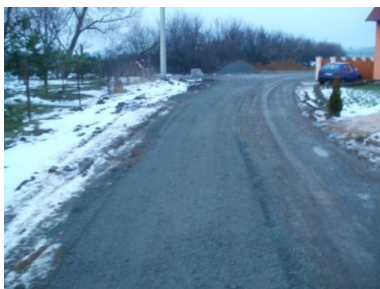
Stoka A – provizorní úprava komunikace
