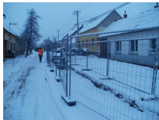
Stoka A – zajištění staveniště
