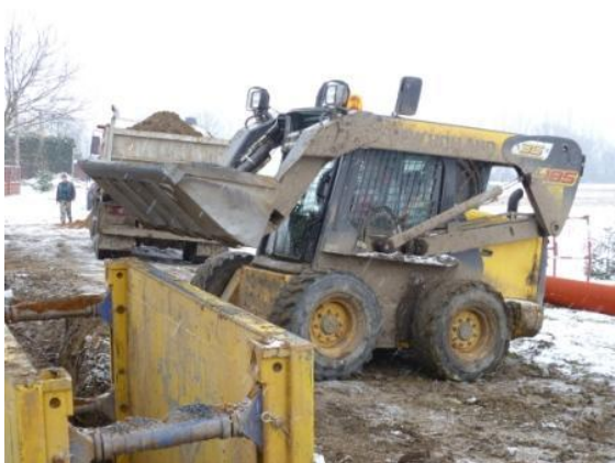
Stoka CA 1-1 – stavební práce
