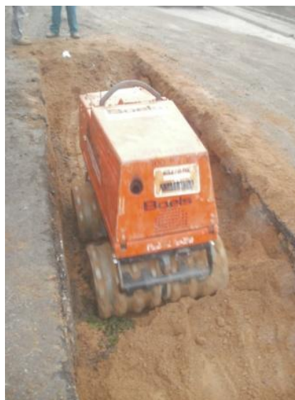
Stoka A – hutnění po výkop. pracech
