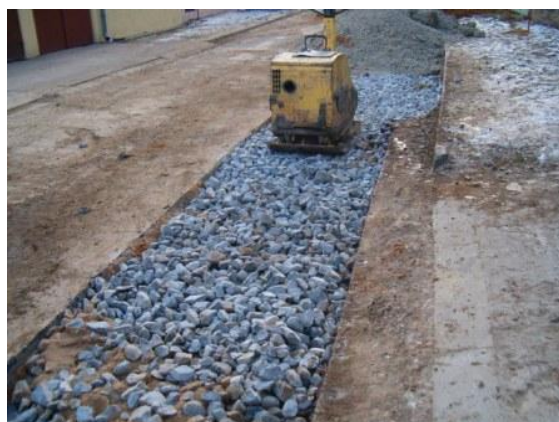
Stoka BA 1-1 – provizorní úprava komunikace
