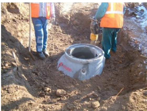
Stoka BA 1-1 – hutnění zásypu po vrstvách kolem kanal. šachty
