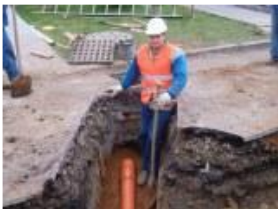
Stoka BD – propojení dešťové vpusti
