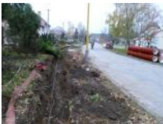
Stoka C – přípravné práce
