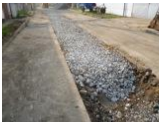
Stoka BD – provizorní úprava komunikace
